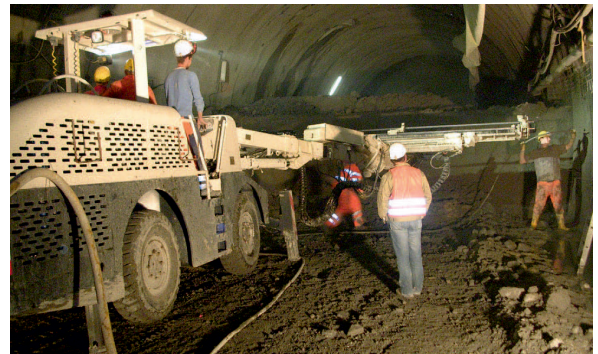
HDT 2P at site in Austria HDT 2P Baustelleneinsatz in Österreich
